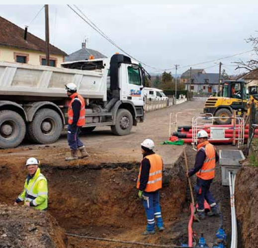
Quartier de Nichet... un morceau de travaux
