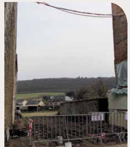
Parking avec trottoir Place des Pentiers
