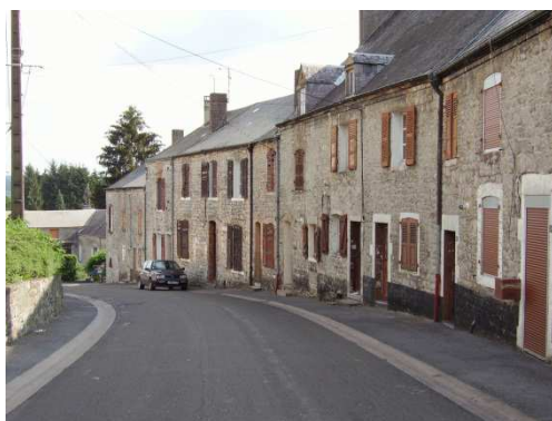
Cité rue A. Malaise vouée à la démolition
