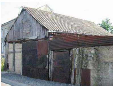
Exemples de bâtiments annexes ou non dénaturant leur environnement immédiat (toitures et/ou bardages en tôles vieillissant mal).
