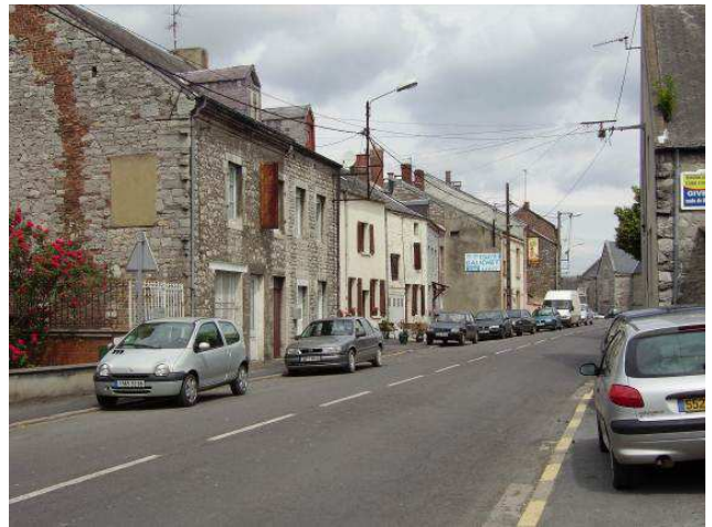
Rue du Poteau
