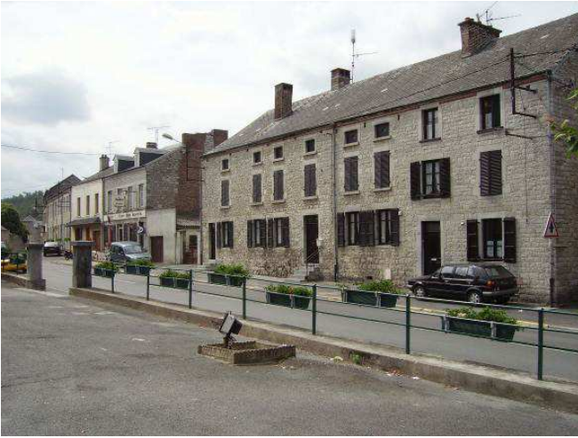
Alignement le long de la rue du Poteau
